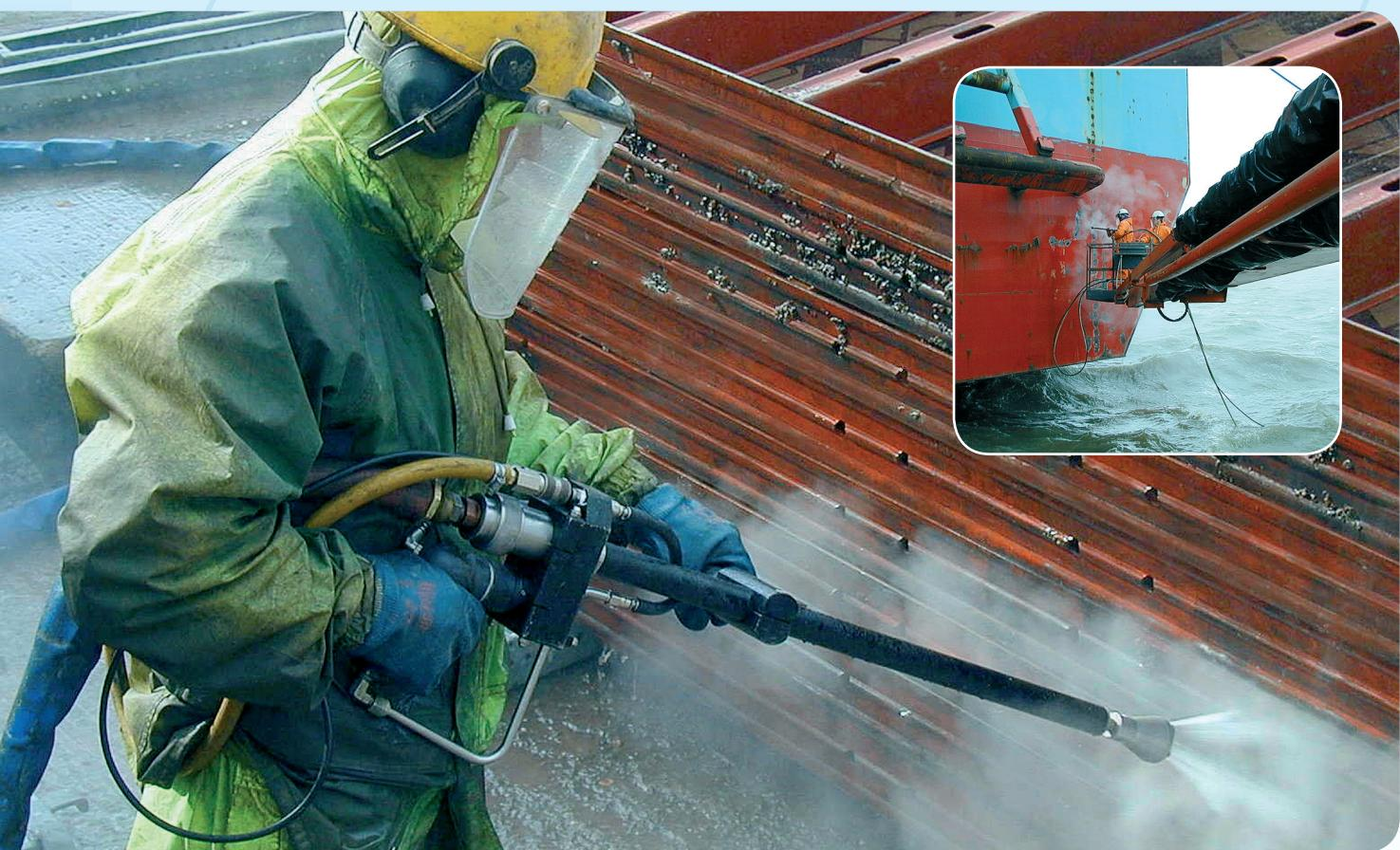
**Hlavní obrázek:** Odstraňování betonu z bednění tlakem 2 500 bar **Výrez:** Příprava povrchu před opravou lodi tlakem 3 000 bar
