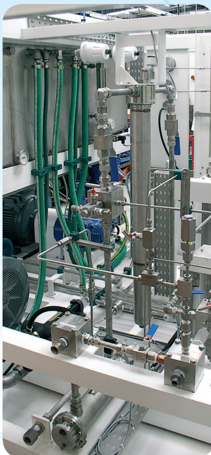
Dvojice čerpadel HPS650 pro průplach a tlakové zkoušení podmořských hadic glykolem
